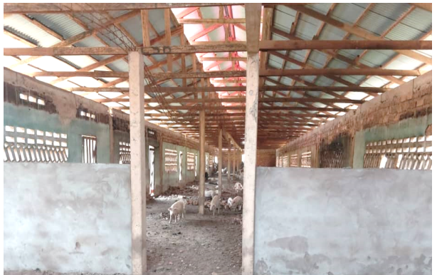
Der Bau der Abtrennungen hat begonnen.
