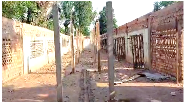
Baubeginn der Stallungen
